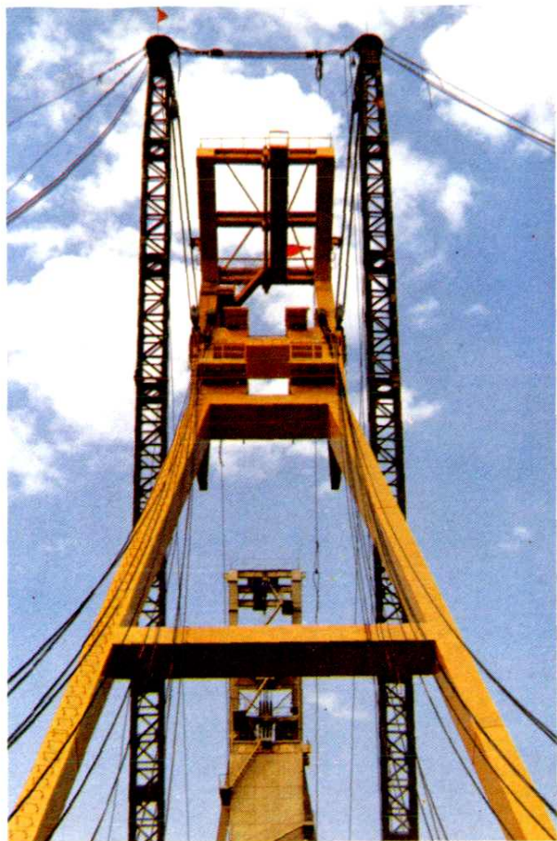
阳泉三矿立井井架整体吊装
