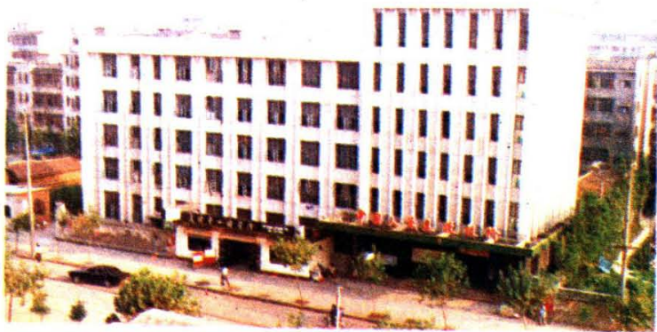
鄂州市建设银行大楼
