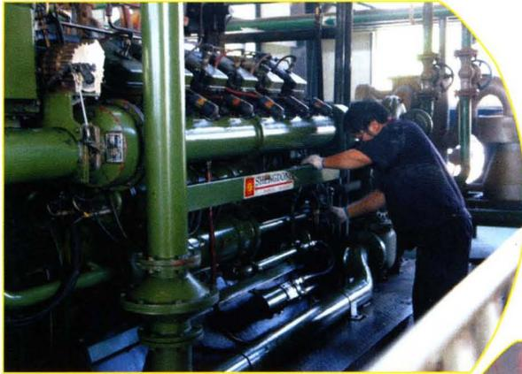
水帘洞煤矿工作人员正在对瓦斯发电机组检查维修
