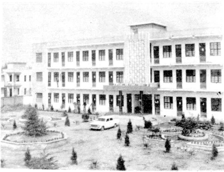
沔城回族镇人民政府大楼
