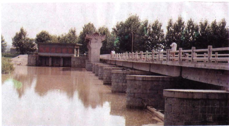
铃铛口枢纽工程
