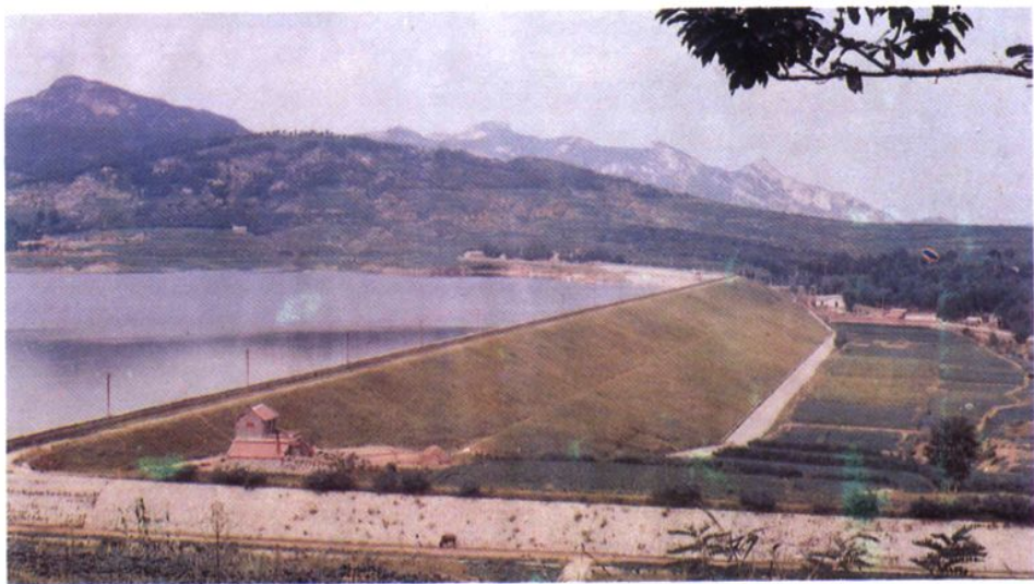
大山水库大坝
