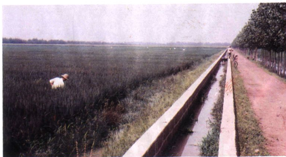
陡山水库灌渠
