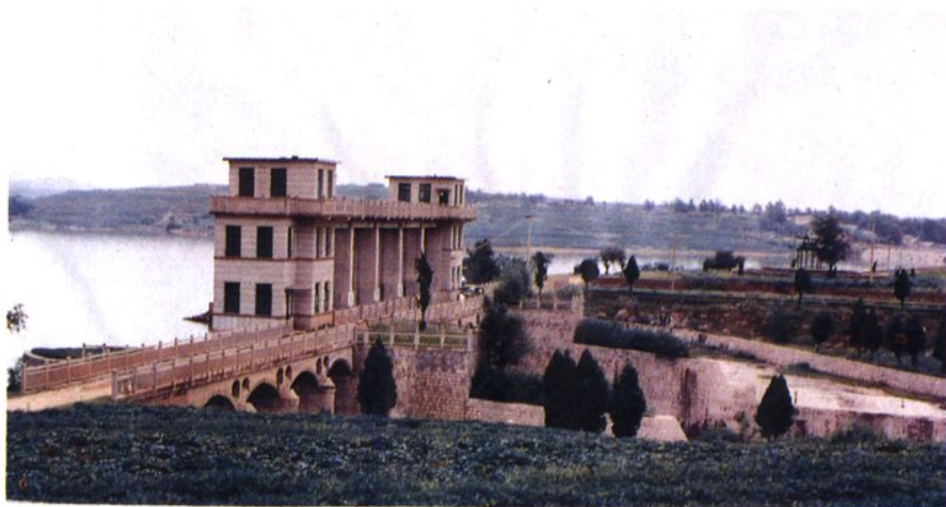
相邨水库溢洪闸
