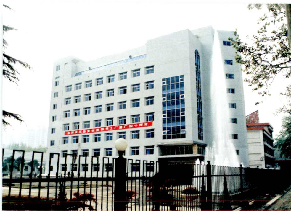
西安铁路信号工厂计试中心大楼
