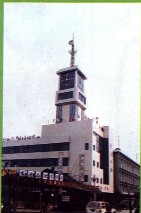
△什邡电信大楼
