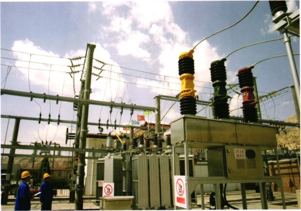
永靖县农网二期改造工程
