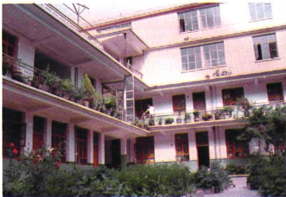
祥云县建筑工程公 司办公宿舍楼
