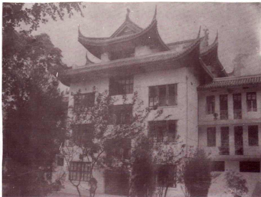
中共柘皋镇党委会、柘皋镇人民政府办公大楼
