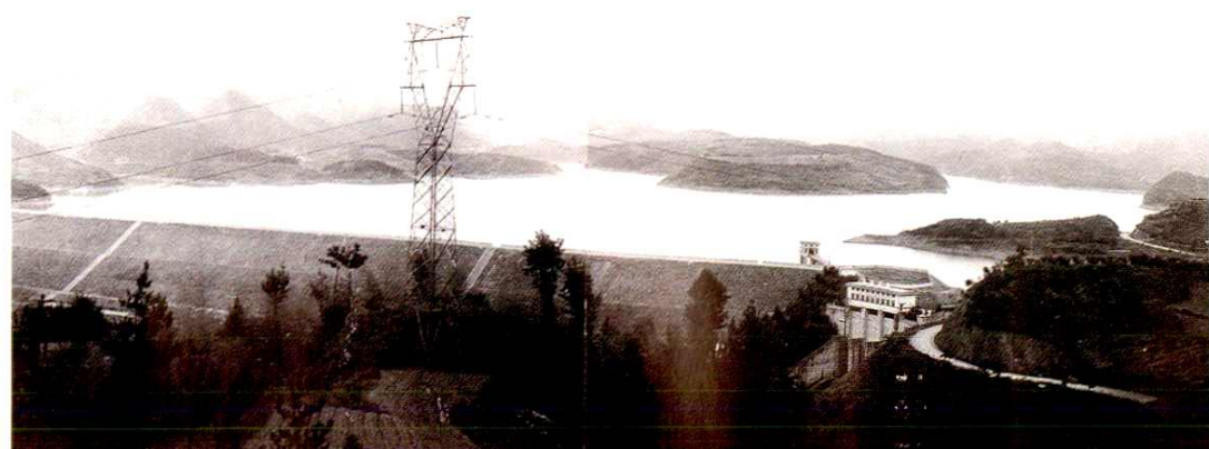
陈蔡水库溢洪闸
