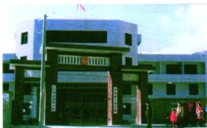
泸定县人民法院办公楼外观
