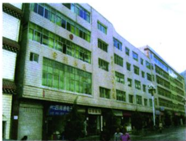
九龙县法院审判大楼
