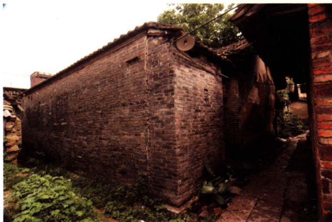
广东省广州市白云区新市镇新科村（科甲水）某住宅全景
