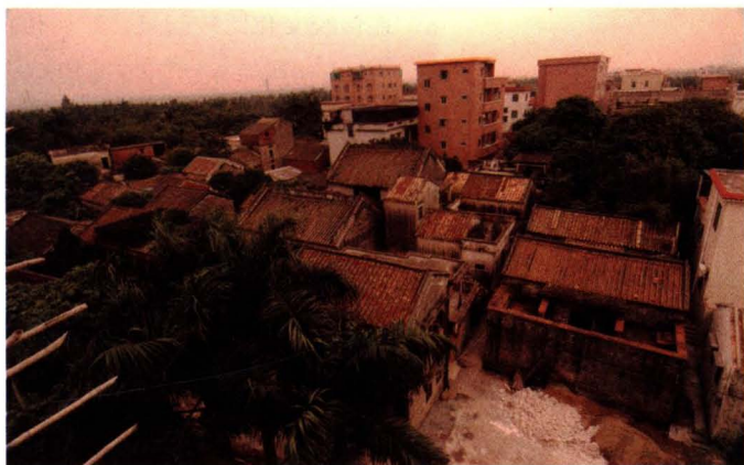
广东省广州市番禺区钟村镇大洲村俯视
