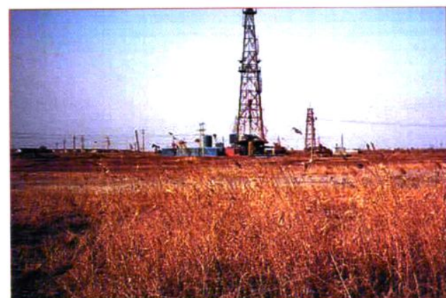
在山东八面河钻井施工
