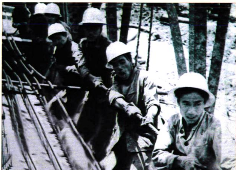
钻井工人发扬大庆艰苦 奋斗精神——人力穿井 架大绳和背运固井水泥
