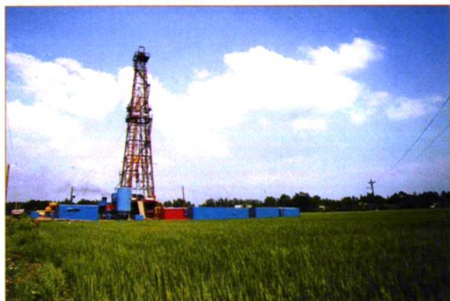
在河南南阳油田安棚钻井施工
