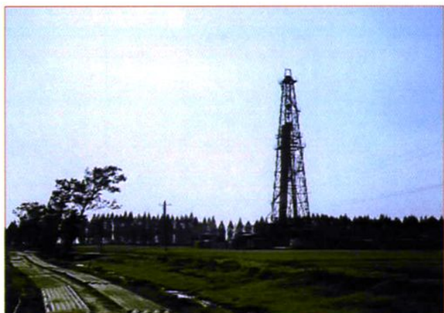
在广东三水钻井施工
