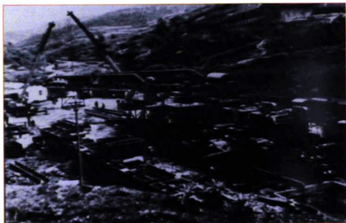
在鄂西山区安装钻井设备
