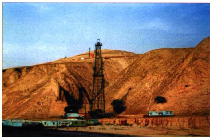
在长庆油田坪北钻井施工
