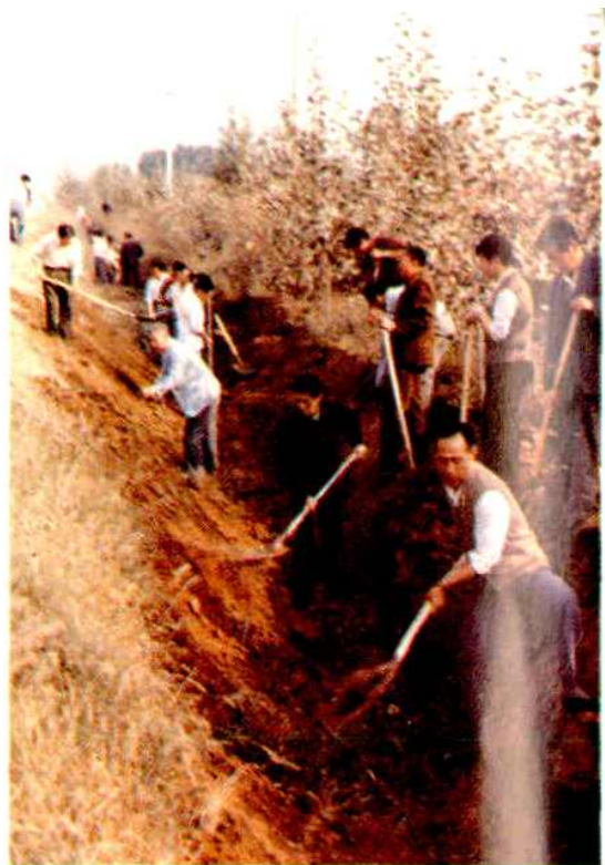
交通局领导在公路养护中（祁跃明摄）
