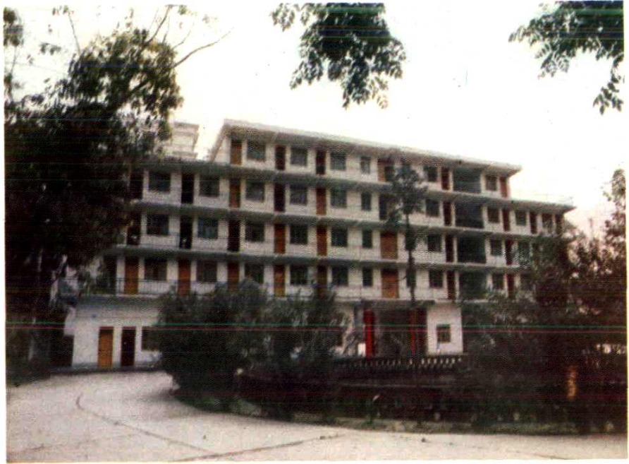
中共平昌县委办公大楼
