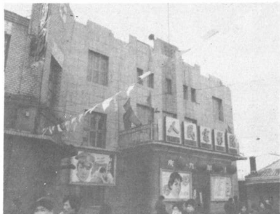
人民电影院位于北市场街东滨翠里六号，建筑面积1.339平方米，该楼建于1937年，是鸿增祥丝房资本家李云阁投资1万元修建根据自己名称为云阁电影院。
