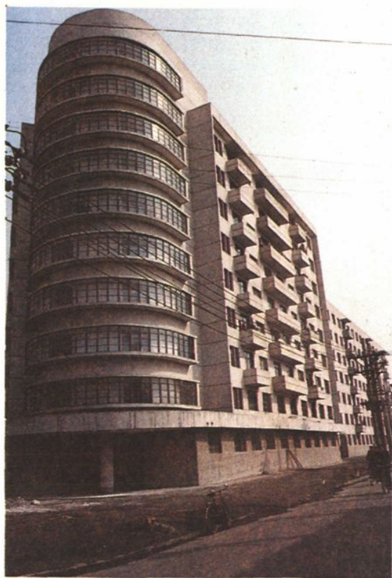
▶ 八五年交付使用。 一、二队修建的高层建筑住宅楼，一九 富贵里高层住宅楼，是和平区房地产局
