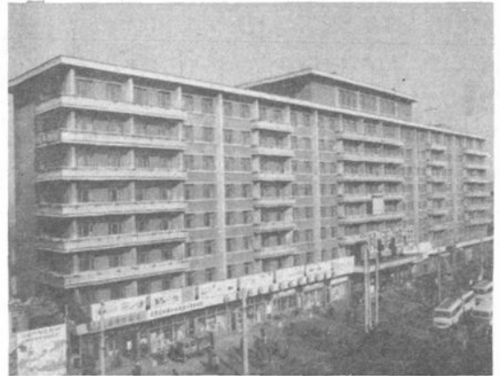
和平旅社位于胜利街3段28号，1975年建成，建筑面积16.654平方米。
