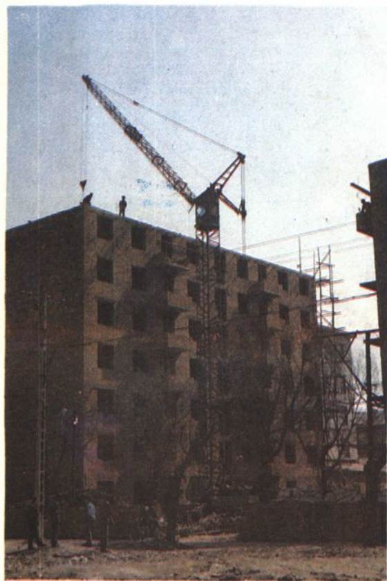
◀ 局属第一工程队正在施工中同泽街现场。
