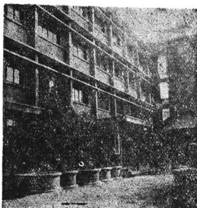
新都县商业局办公大楼
