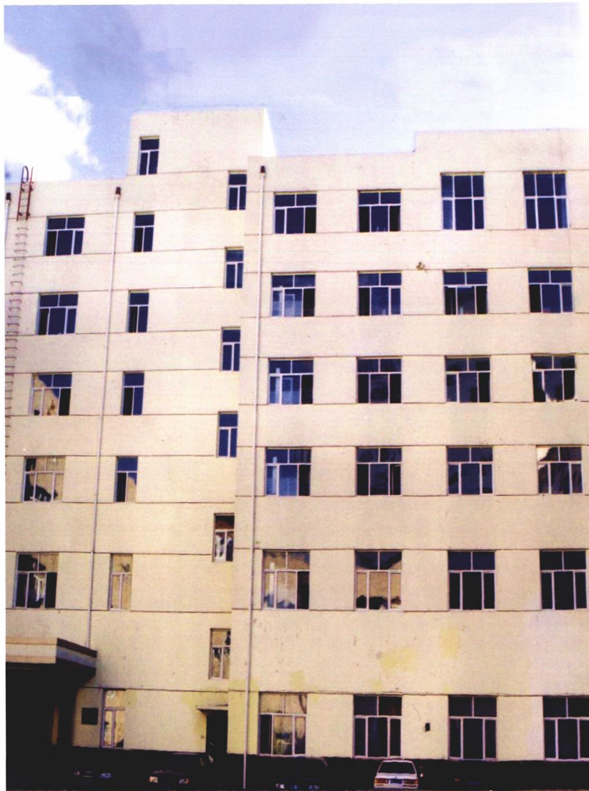
建华区党政办公中心主楼
