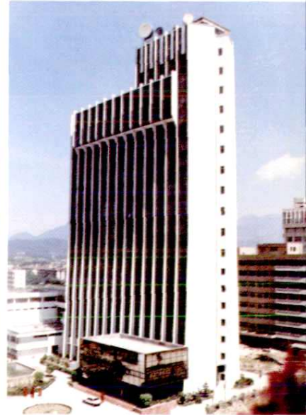
省电网中心调度所
