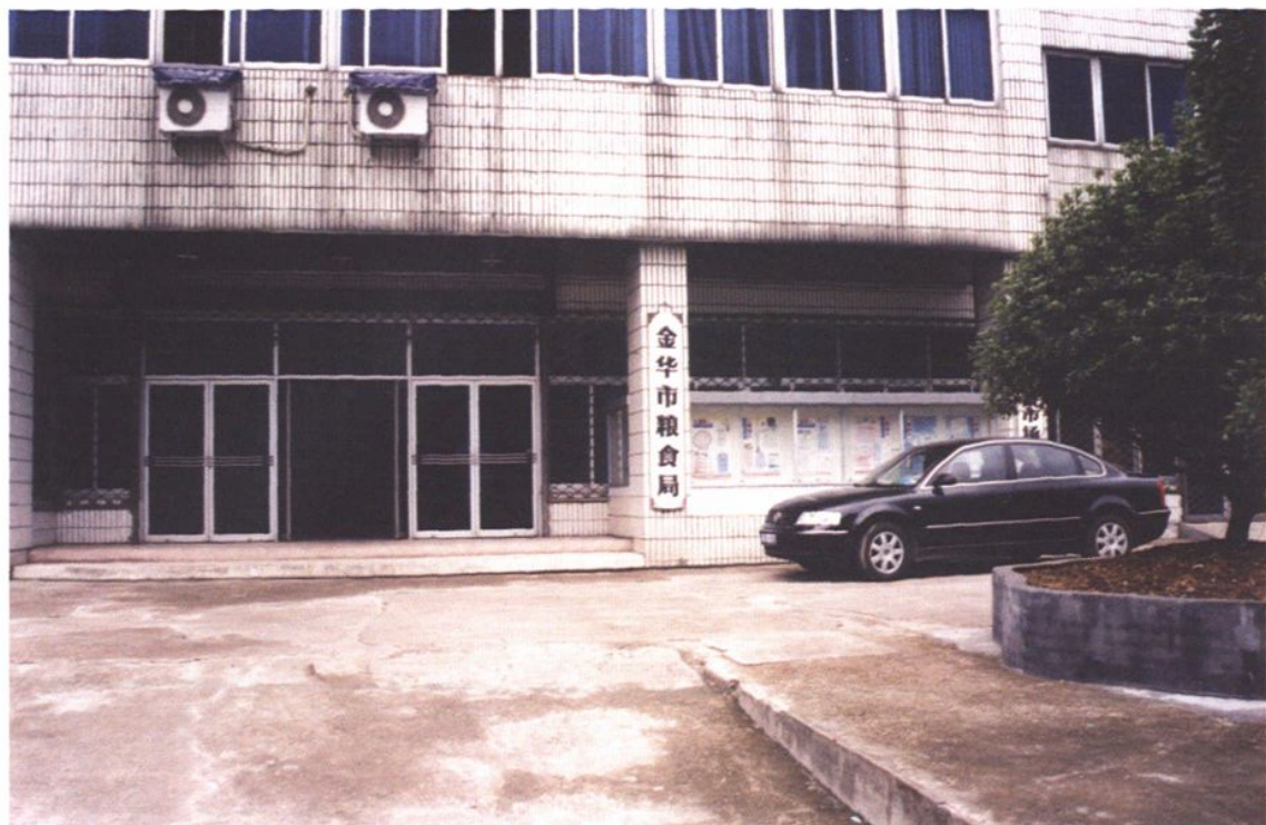
金华市粮食局办公楼 地址：婺江西路 740 号
