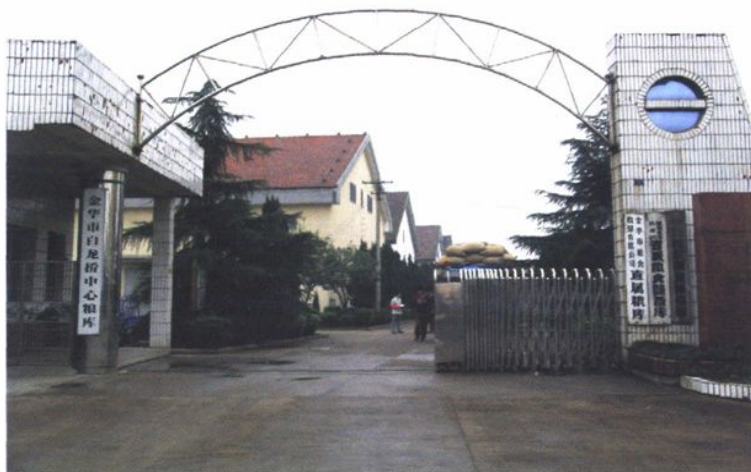
金华市粮食收储公司白龙桥直属粮库
