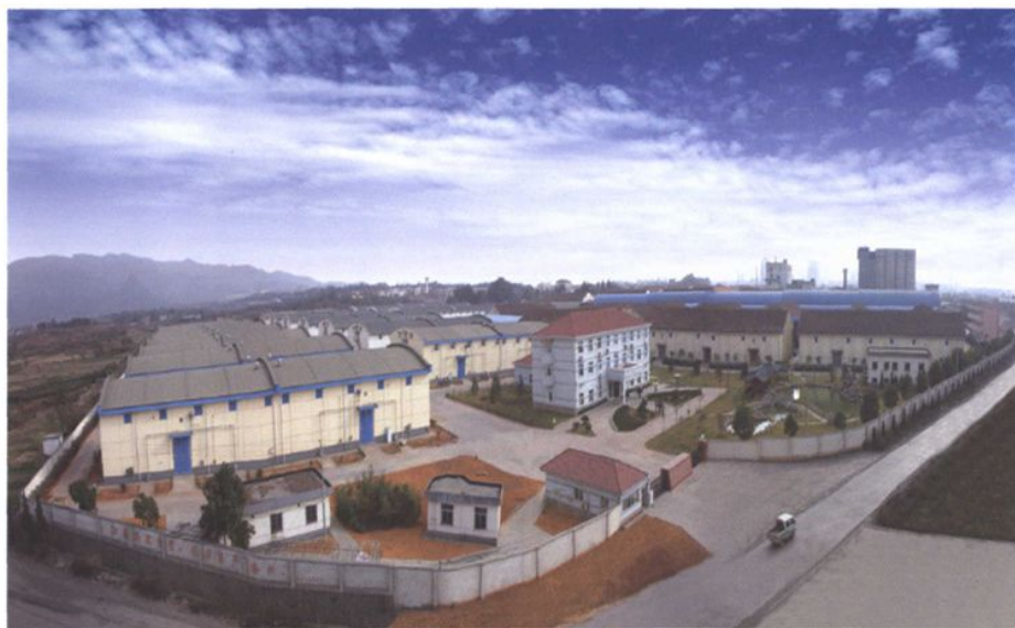
中央储备粮 金华直属库全景
