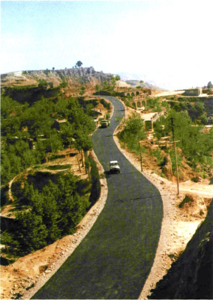
1964年铺装的简易沥青（渣油）路面
