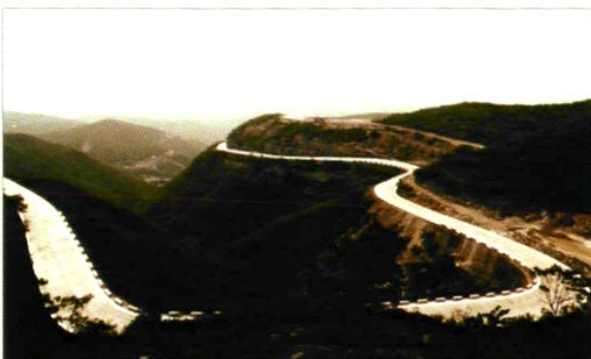
207国道山西境内安保工程
