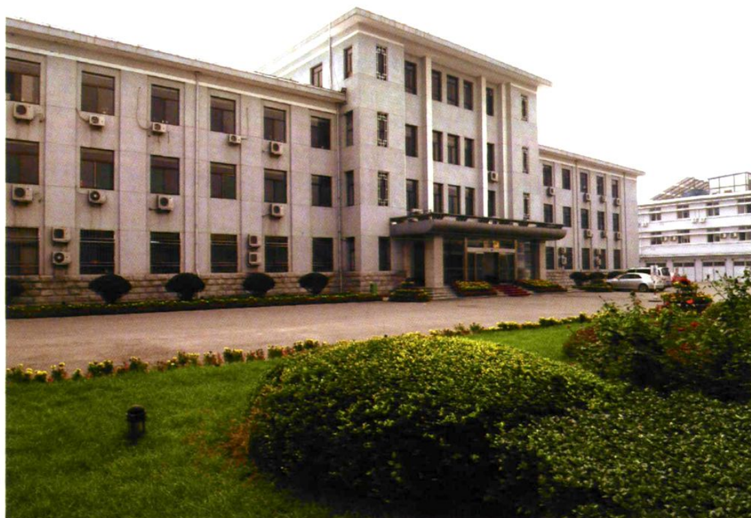
山西省公路局办公楼位于太原市师范街20号，1959年初建 建成一层后停建 1971年续建二层、三层 1984年续建四层
