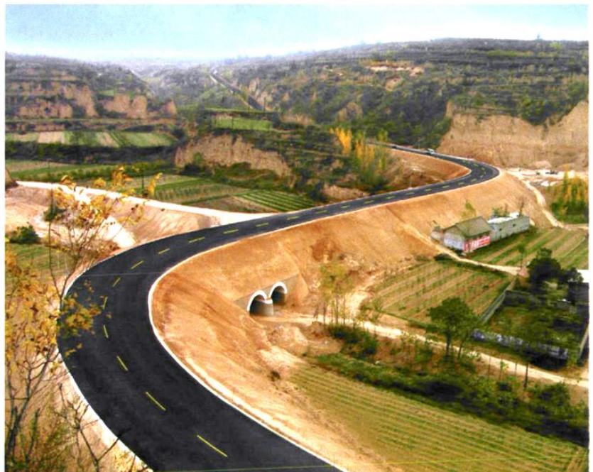
沿黄河扶贫旅游公路 运城岳沟村路段
