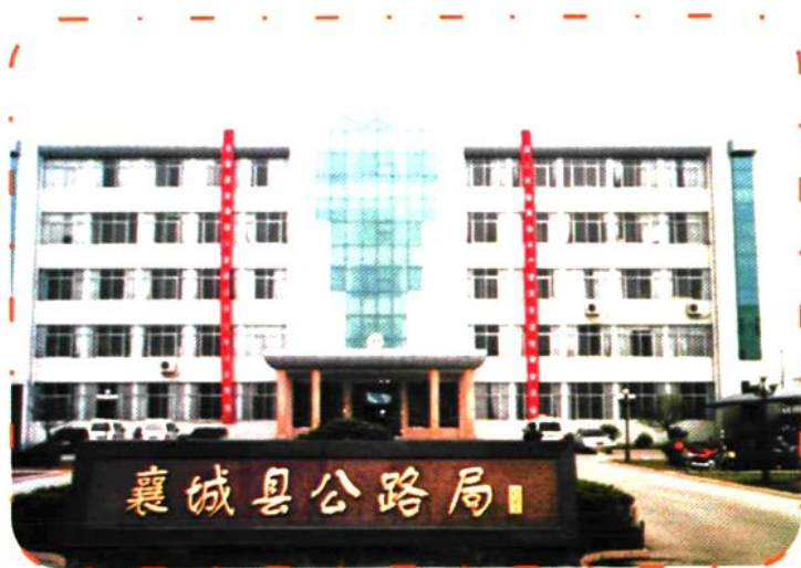
机关办公大楼
