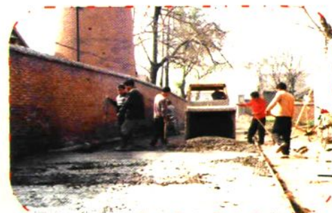
背街小巷施工
