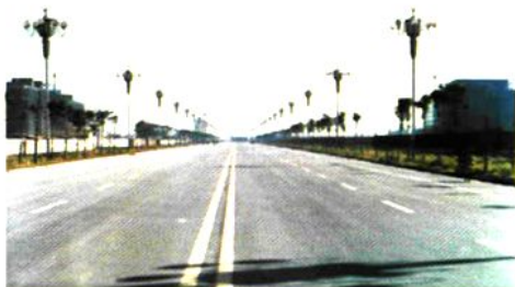
襄城县公路管理局承建的中心路东段
