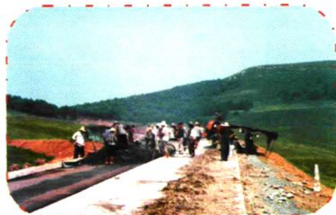
山区路段施工
