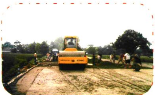
混凝土路面碾压
