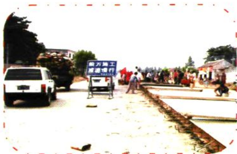
混凝土路面施工
