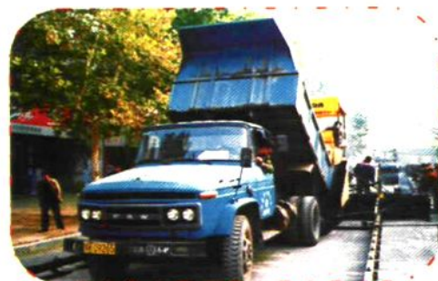
沥青面层铺筑
