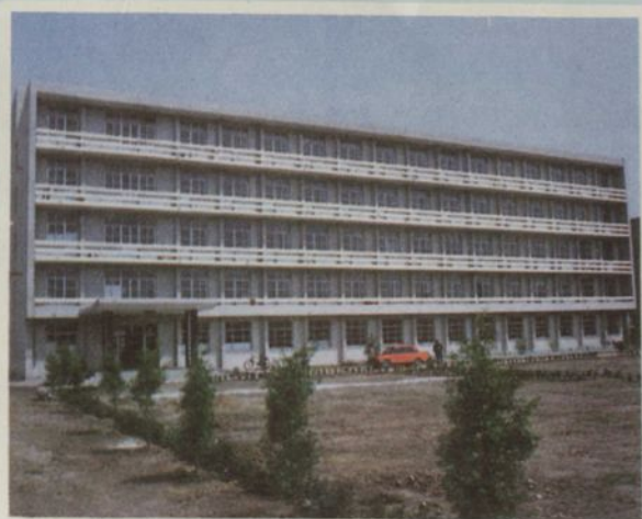
地区中医院住院部
