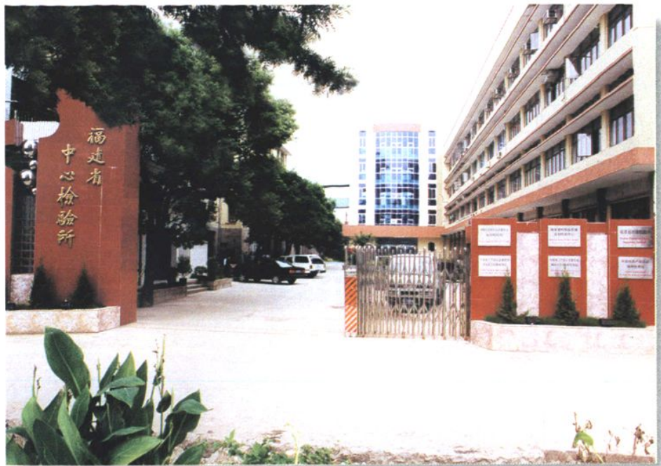
福建省中心检验所实验楼
