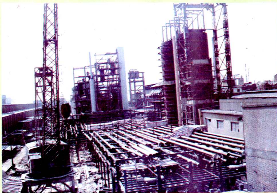
引进西德管道溶出脱硅系统安装
