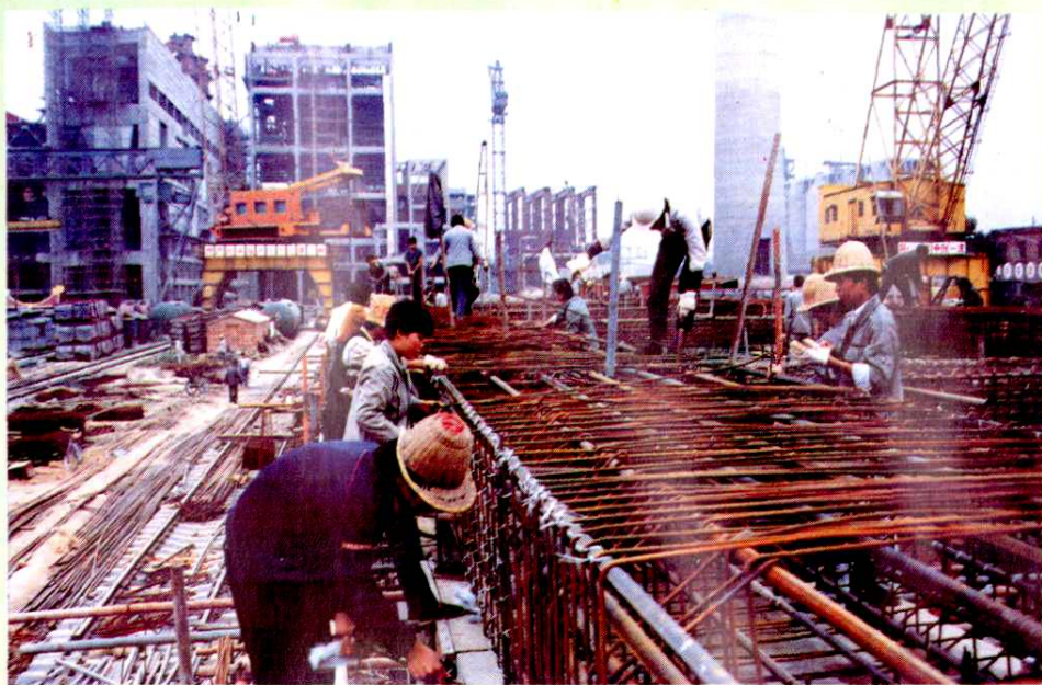
郑州热电厂 2 \times 20 万瓩供热机组建筑工程，进入施工高潮（侯亚亮 供稿）
