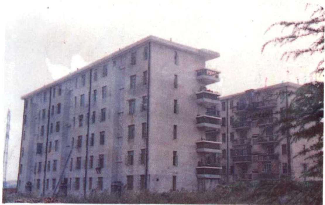
教工宿舍楼一角
