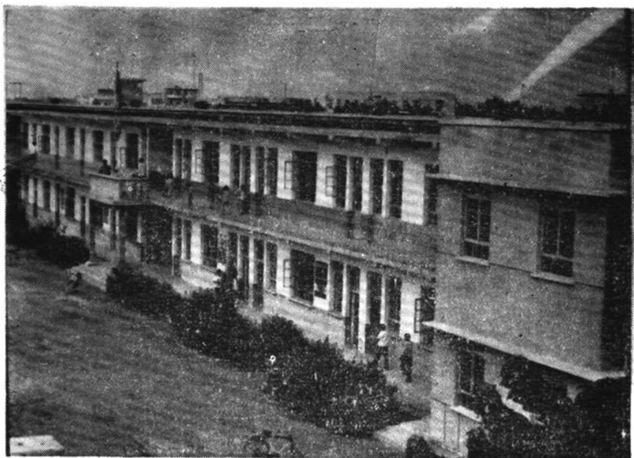
实验小学办公楼
