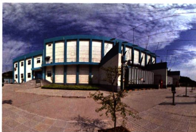
△220千伏化工变电站
