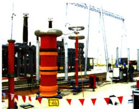
△220千伏GIS交流耐压试验现场
