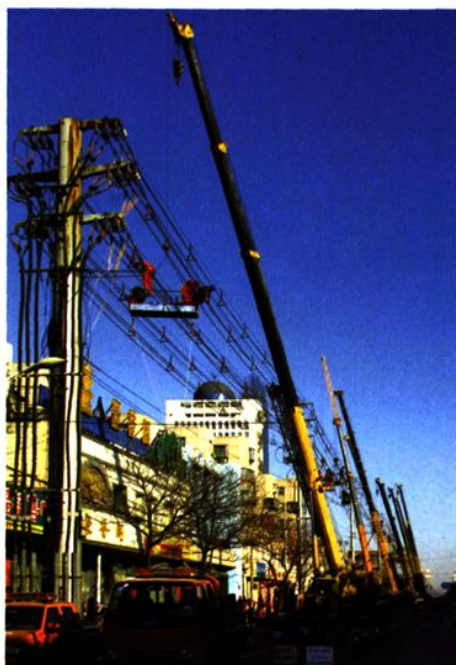
△张店变电站6回出线三角支架更换工程现场
