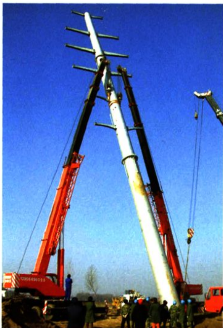
△110千伏线路架设现场
