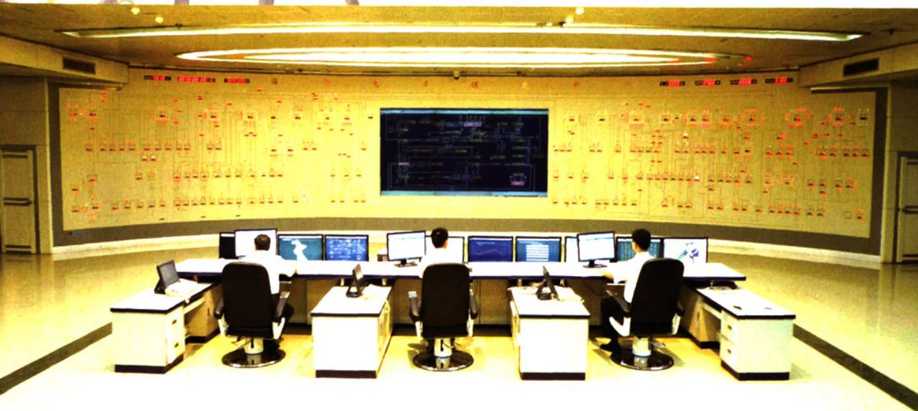
△淄博电力调度中心
