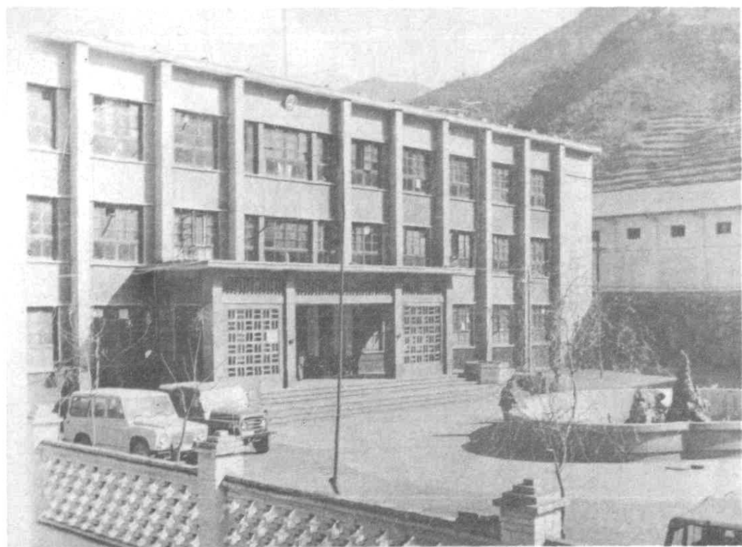
县政府办公大楼
