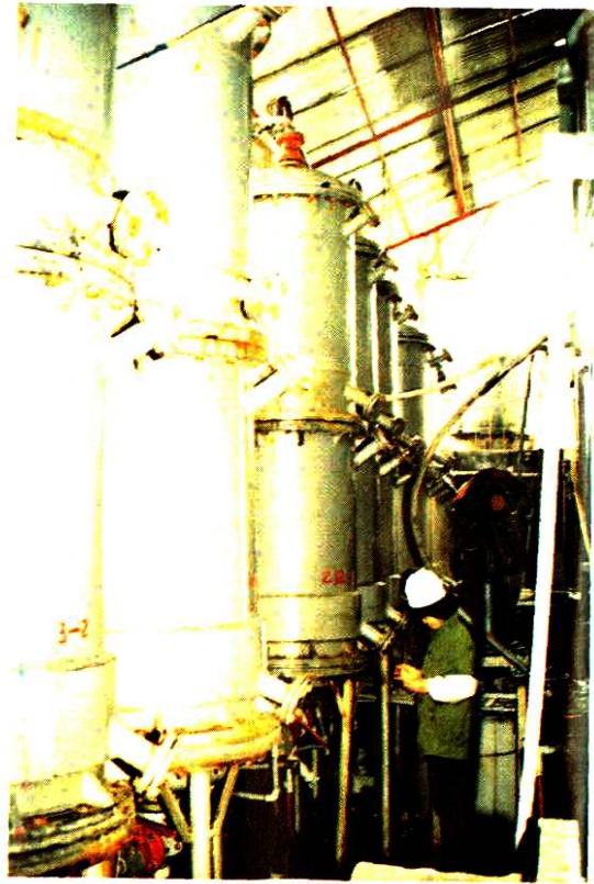
▲ 成都制药十一厂生产车间
