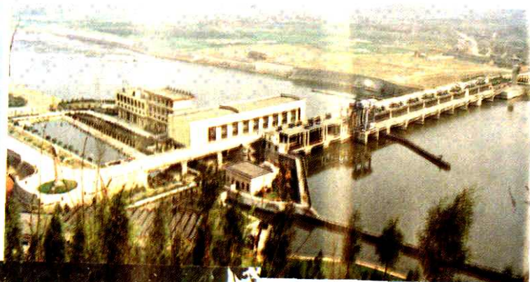
▲沱江明珠——金堂九龙滩 水电站
