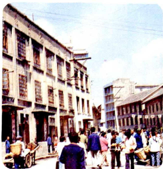
镇雄县农资日杂公司大楼
