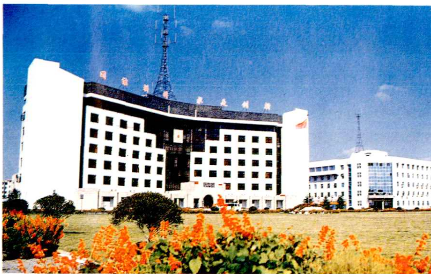
常熟市人民政府办公大楼
