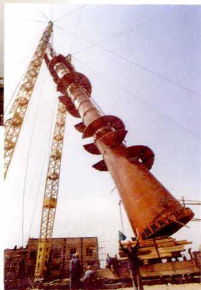
吊装异丁烷塔
