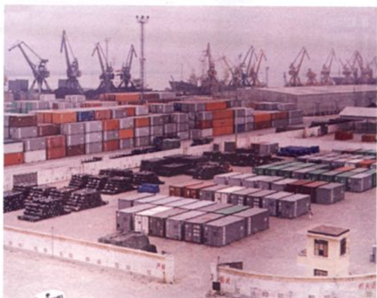
省外运公司集装箱堆场
