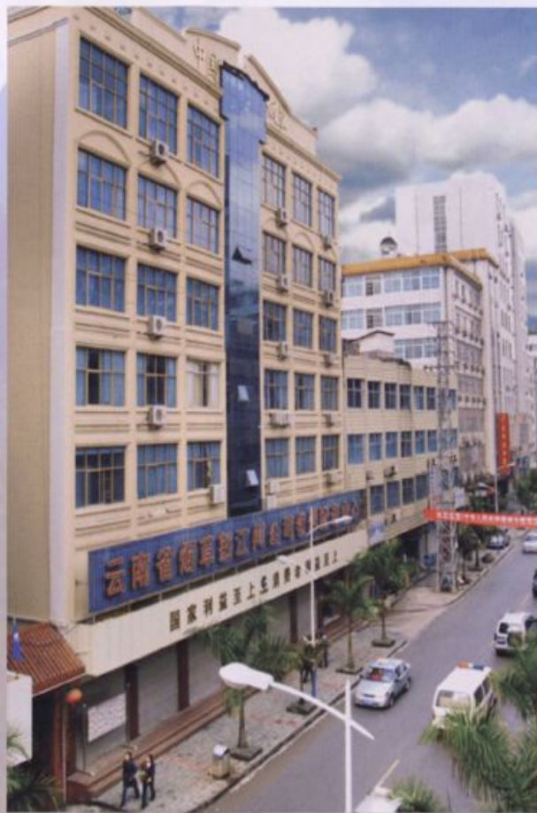
云南省烟草公司怒江州公司办公楼
