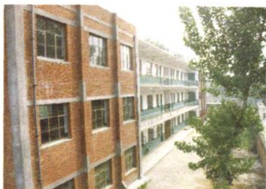
设施齐全、现代化的实验大楼
