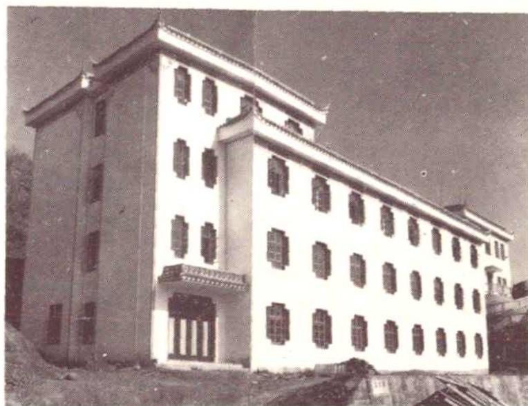
● 镇建筑工程队承建的县中医院
