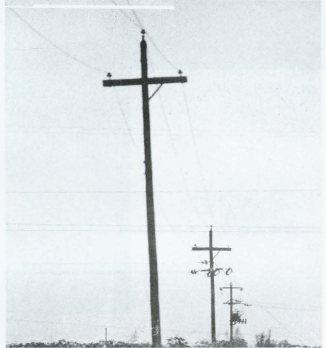
35千伏水泥杆输电线路
