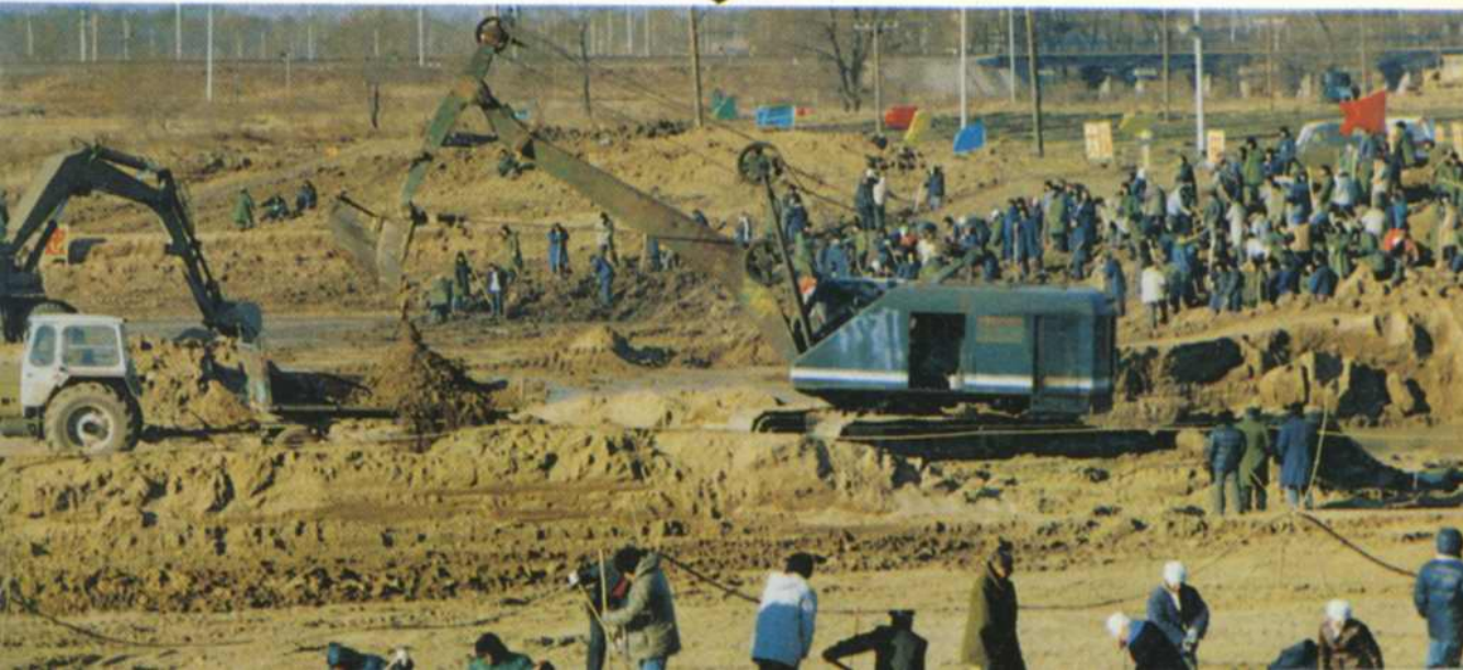
▼治理北沙河工地
