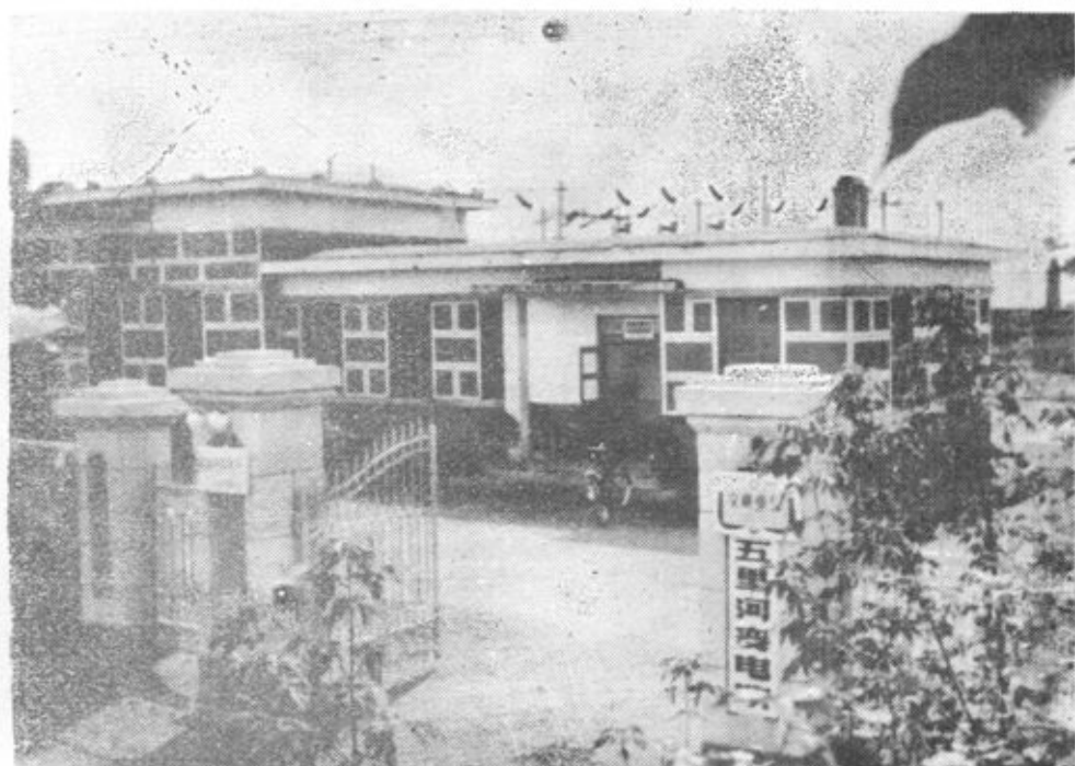
永吉县五里河变电所
