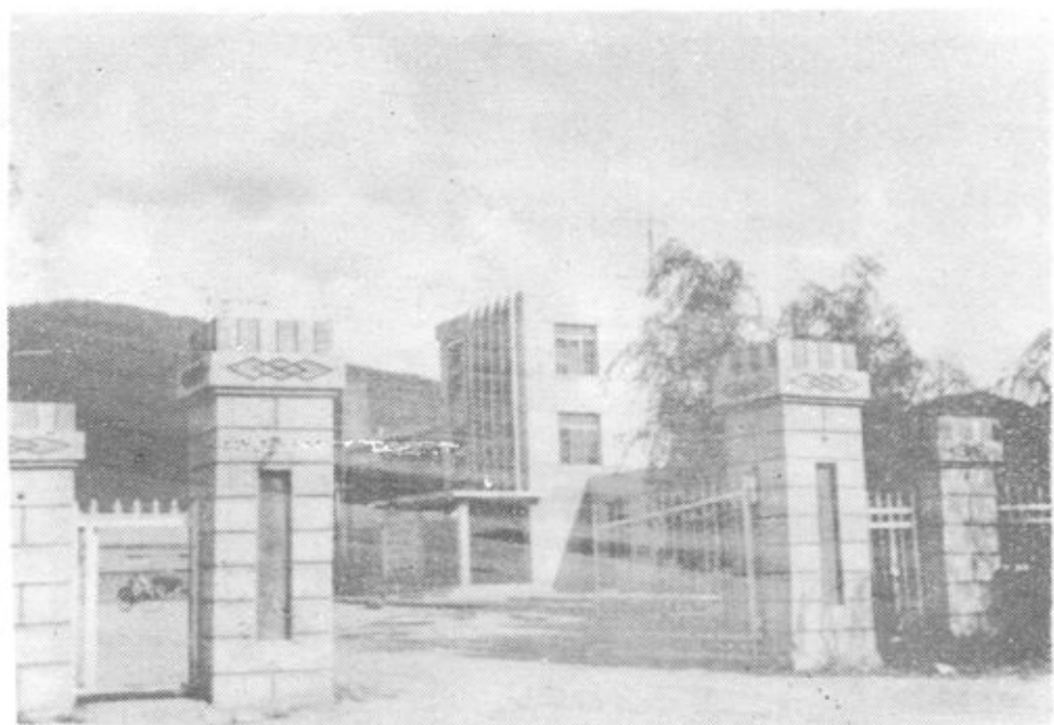
县朝阳水库办公楼
