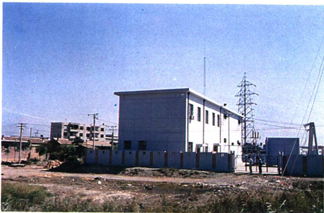
93年2月新建成的双港35KV变电站
