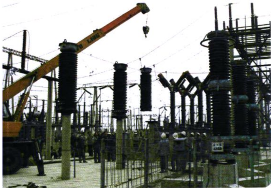
220千伏变电站安装
