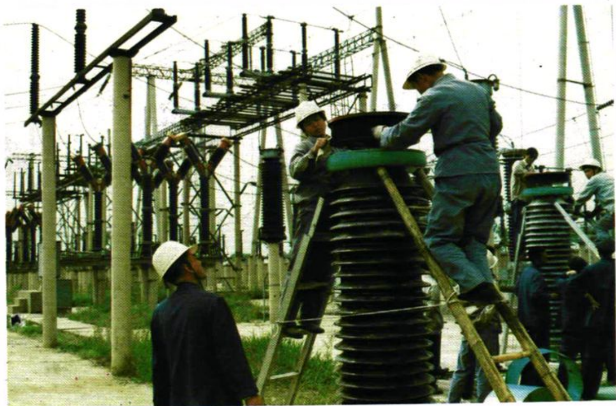
220千伏变电站检修
