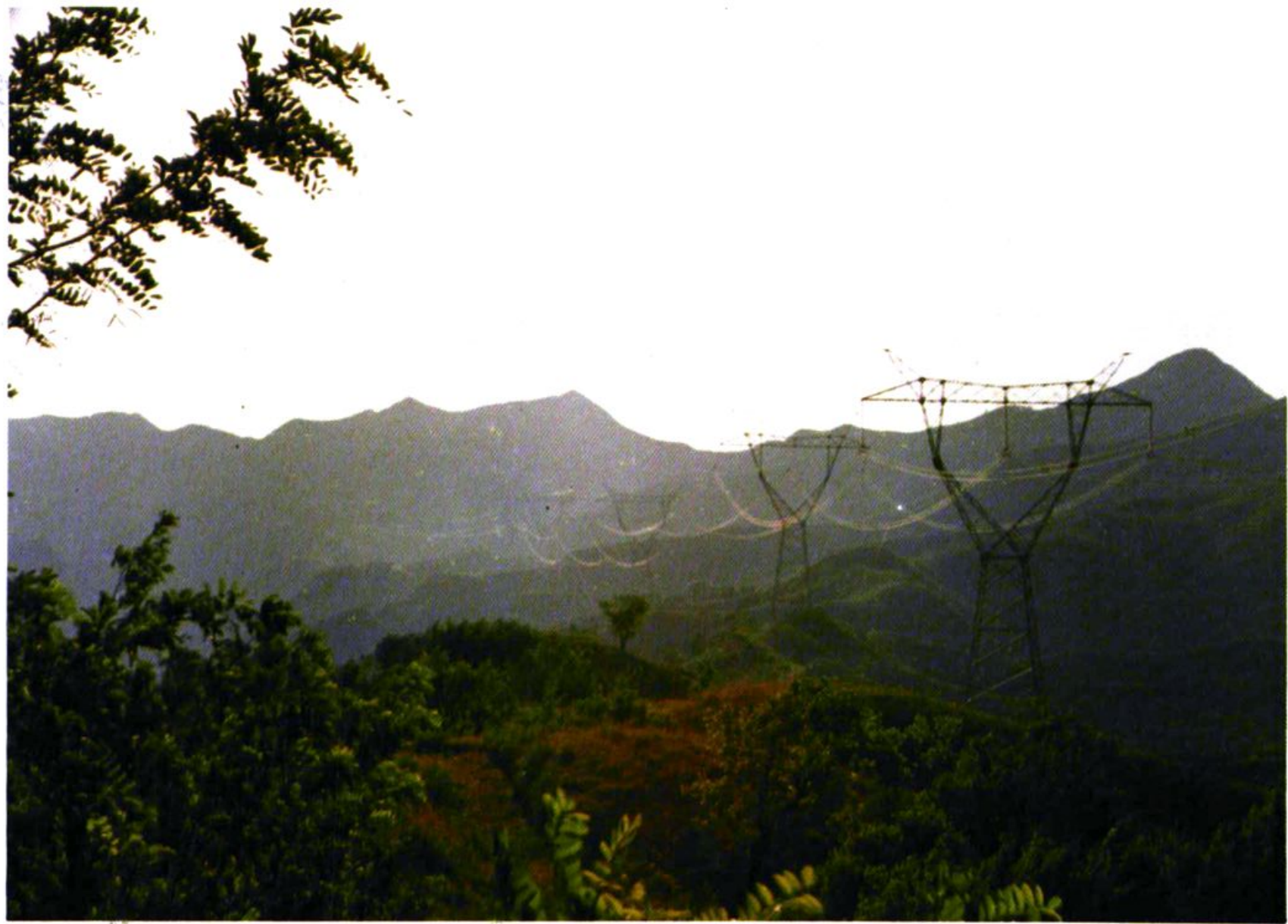
500千伏输电线路跨越太行山
