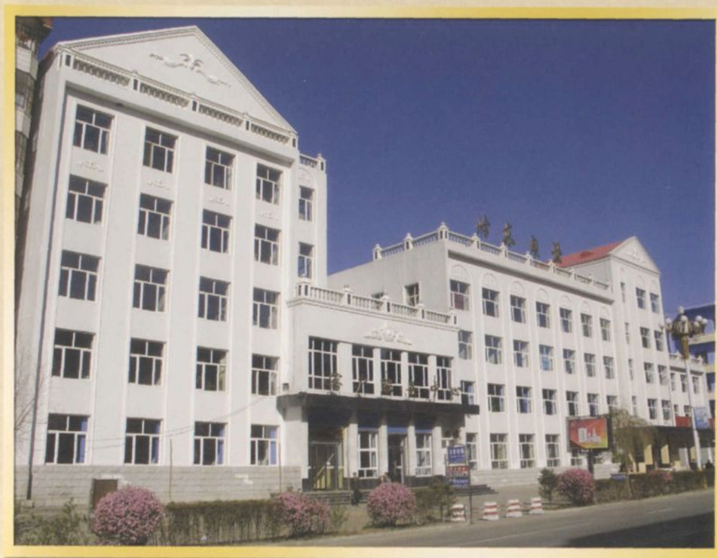
扎兰屯供电局办公大楼
