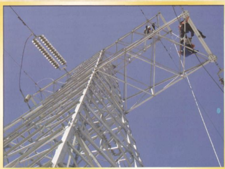
检修220千伏线路
