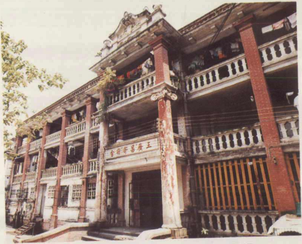
建于一九一八年用竹筋代替钢筋的混凝土大楼——培正中学内 王广昌寄宿舍
