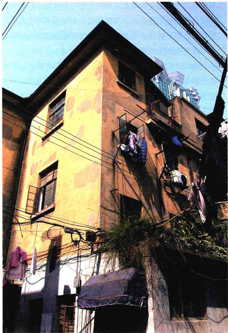
图2（金城别墅楼房）楼里人家的历史，也许正像这楼房墙面上的斑驳。
