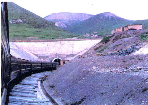
关角铁路隧道
