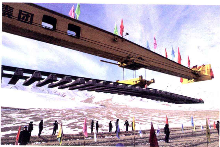
青藏铁路铺架昆仑山
