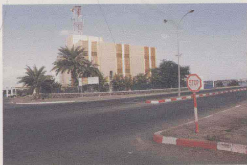
吉布提电讯大楼
