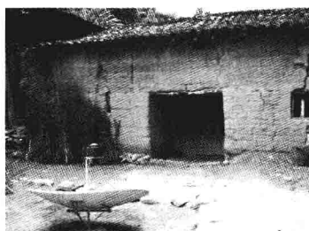
图 1.4 甘肃某夯土民居
