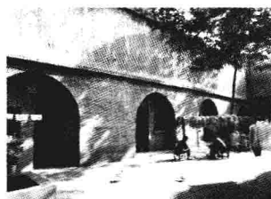
图 1.2 河南巩县某下沉式窑洞
