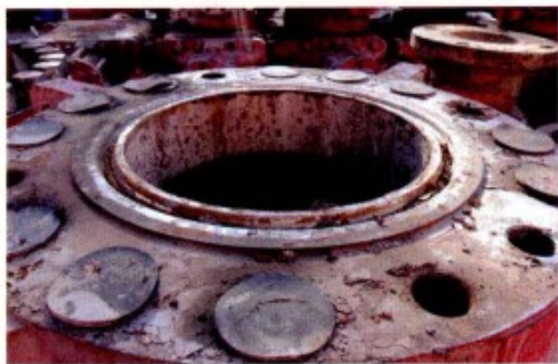
图 1-1-23 不用的螺孔用专用橡胶帽封堵
