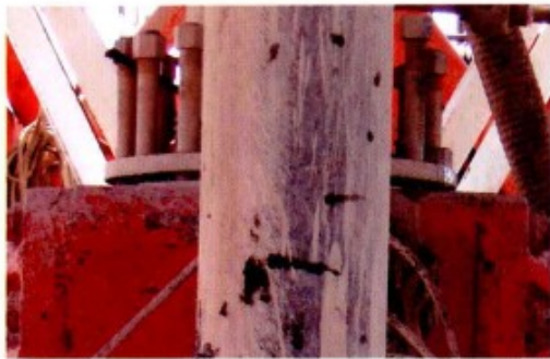
图 1-1-24 不用的螺孔用螺栓封堵
